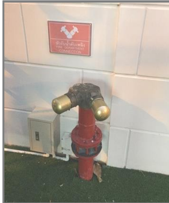
ภาพที่ 15 อุปกรณ์ดับเพลิง
