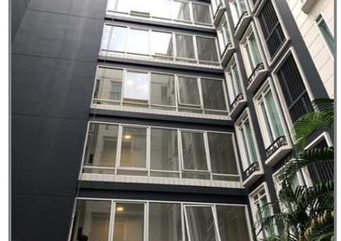
ทางเดินส่วนกลาง ชั้นพักอาศัย
