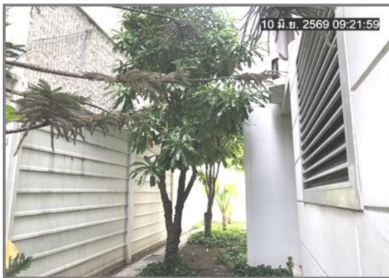
ทิศตะวันตก : ด้านหลัง อาคาร
