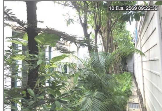
ทิศใต้ : ด้านข้างอาคาร
