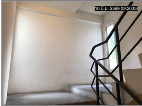
บันไดหนีไฟ
